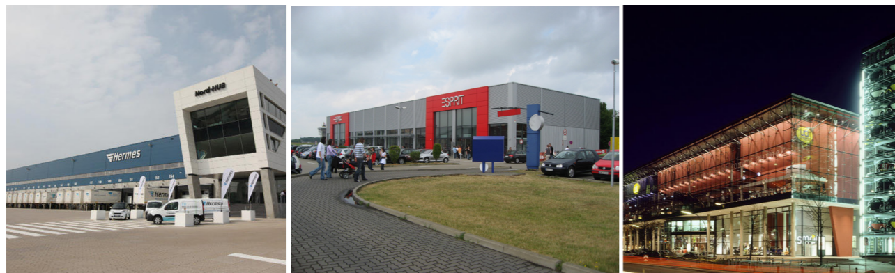
Abbildung 6: Logistikzentrum Langenhagen, Factory-Outlet-Center Stuhr, Urban-Entertainment-Center Hamburg. Quellen: HAZ, 2011 / Eigenes Foto, 2008 / GMP Architekten, 1999
